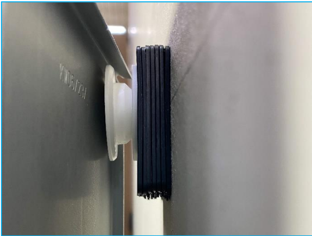
Das umgekanetete Spiegelblech wird in den Exzenter eingehängt.
